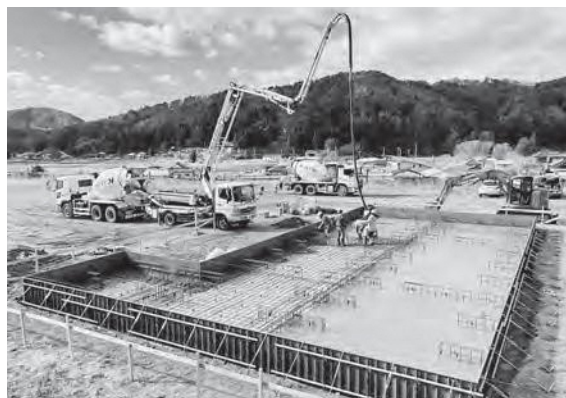
基礎打設の様子
