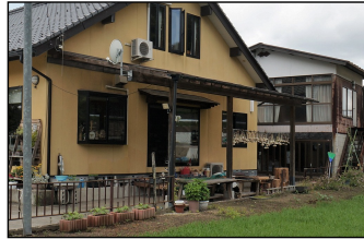
大きな軒下が内部空間のように使用されている例
