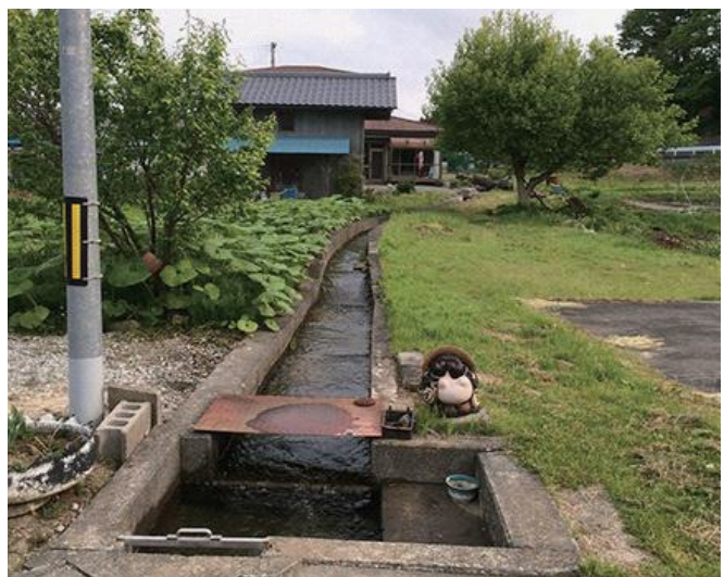
町分地区の隅々に清らかな水を運ぶ水路
