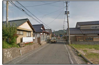
勾配屋根が並ぶまち並み
