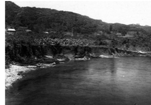
1941年 大水害による被害惨状
