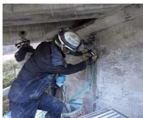
コンクリートコア抜き
