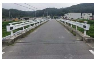
起点側から撮影
