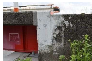
主桁端部再塗装、橋台打替工
