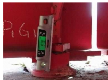
支承傾斜調査
