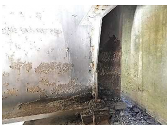
主桁端部の腐食(板厚減少)
