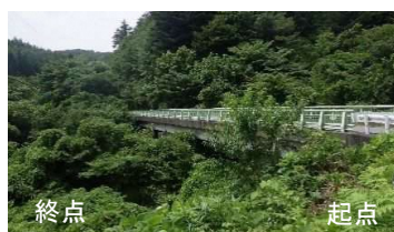
67. 手古岡橋 ポステンT桁橋、橋長：51.20m 1991年竣工 判定区分：「Ⅲ」
