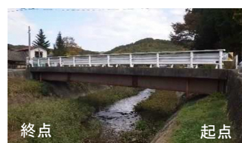
1. 原橋 鋼桁橋、橋長：20.33m 1978年竣工、1級村道 判定区分：「Ⅰ」
