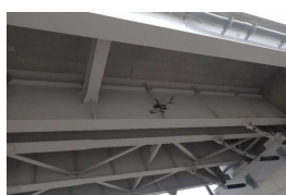
ドローンによる桁下の点検
