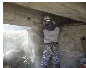
コンクリートはつり調査
