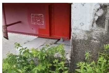
支承取替工、縁端拡幅工
