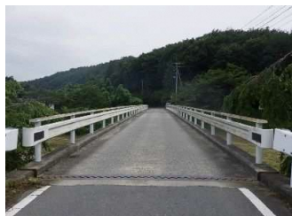
起点側から撮影
