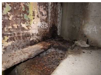
主桁端部の腐食(板厚減少)
