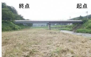
補修前（令和4年）（左側）
