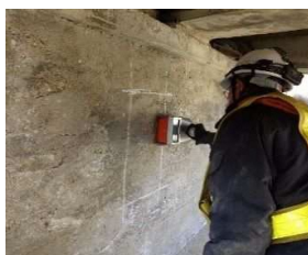
鉄筋レーダー探査
