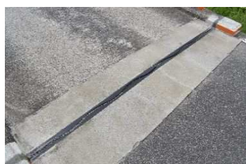
伸縮装置取替工
