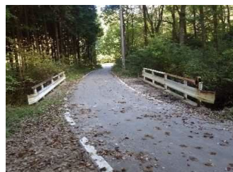
起点側から撮影
