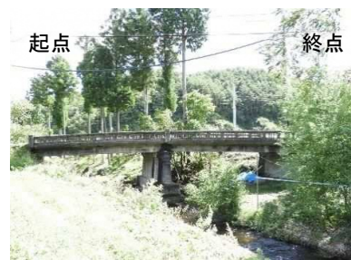
補修前（平成29年）（右側）
