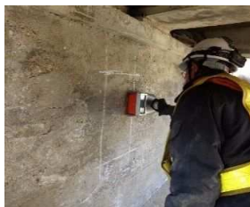
鉄筋レーダー探査
