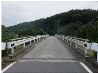
起点側から撮影
