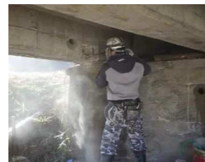
コンクリートはつり調査
