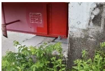
支承取替工、縁端拡幅工
