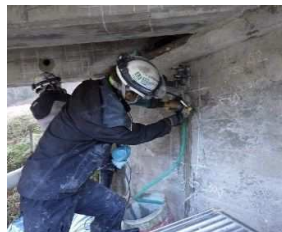
コンクリートコア抜き
