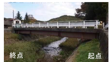
1. 原橋 鋼桁橋、橋長：20.33m 1978年竣工、1級村道 判定区分：「I」
