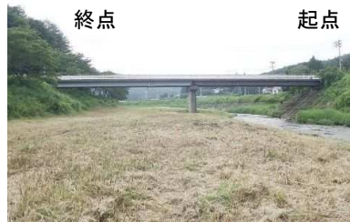
補修前（令和4年）（左側）
