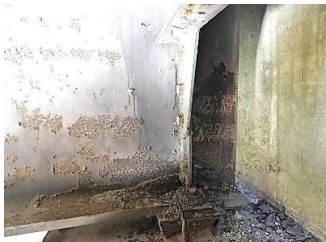
主桁端部の腐食(板厚減少)
