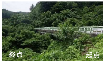
67. 手古岡橋 ポステンT桁橋、橋長：51.20m 1991年竣工 判定区分：「III」
