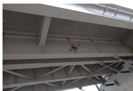
ドローンによる桁下の点検
