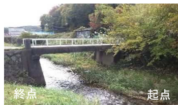
43. 前谷地2号橋 プレテン床版橋、橋長：16.00m 1962年竣工 判定区分：「II」
