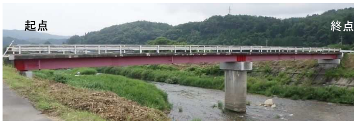
64. 沼田橋 補修後(令和4年)の全景(右側から撮影)
