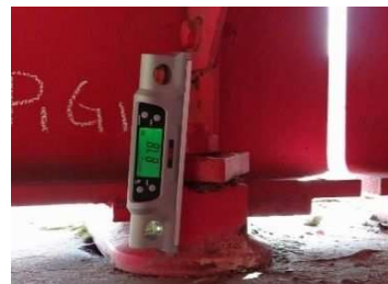
支承傾斜調査
