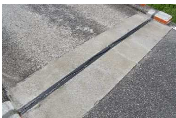
伸縮装置取替工
