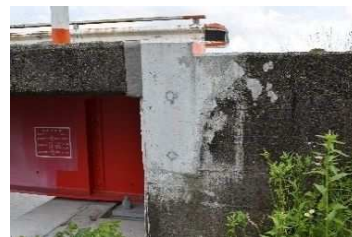
主桁端部再塗装、橋台打替工
