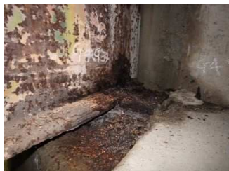
主桁端部の腐食(板厚減少)
