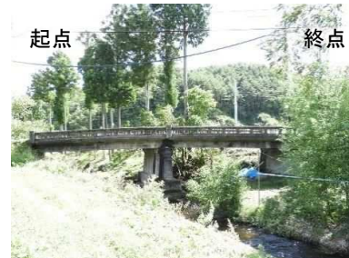
補修前（平成29年）（右側）
