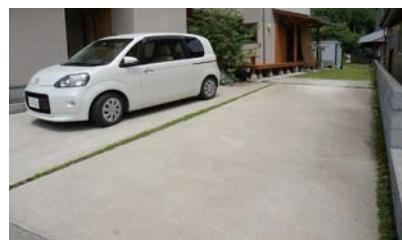
駐車場をコンクリート打ちにする場合は、粗めの表面仕上げにすると見た目の固さを和らげてくれます。また、分節化して目地に緑を入れるとより印象が良くなります。
