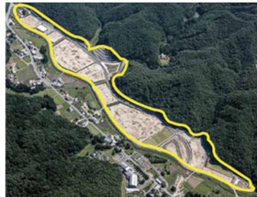
田ノ入工業団地・国県道バイパス整備
