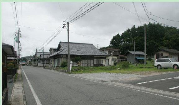
現国道399号の現況写真
