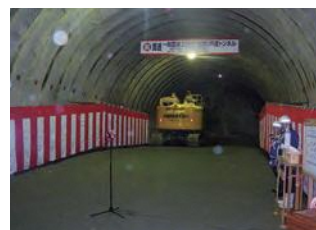
貫通前の戸渡トンネル坑内
