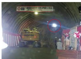
貫通したトンネル
