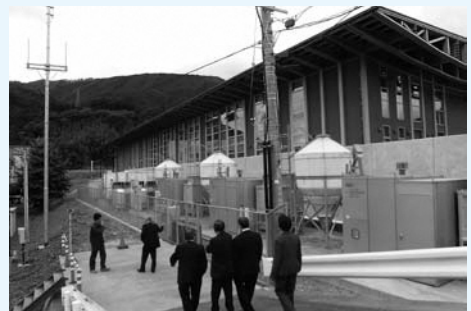
住田町産材を使用し建設された住田町役場と庁舎暖房用チップボイラー
