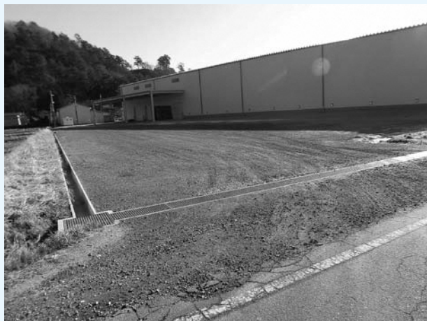
未舗装の米備蓄倉庫
