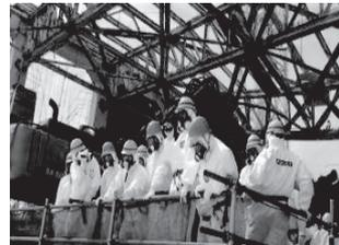
5階における使用済燃料プール水面と床面の水平度を測定する方法の確認の様子。
